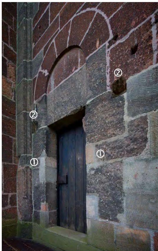
Severní vstupní portál do prvního patra věže v pohledu od severozápadu. 1 – nově vložené kvádry v místech dodatečných kapes, do kterých byla zavázána madla předešlého schodiště. 2 – kapsy po vzpěrách stříšky (?). Foto: Kateřina Neumannová 2017.
