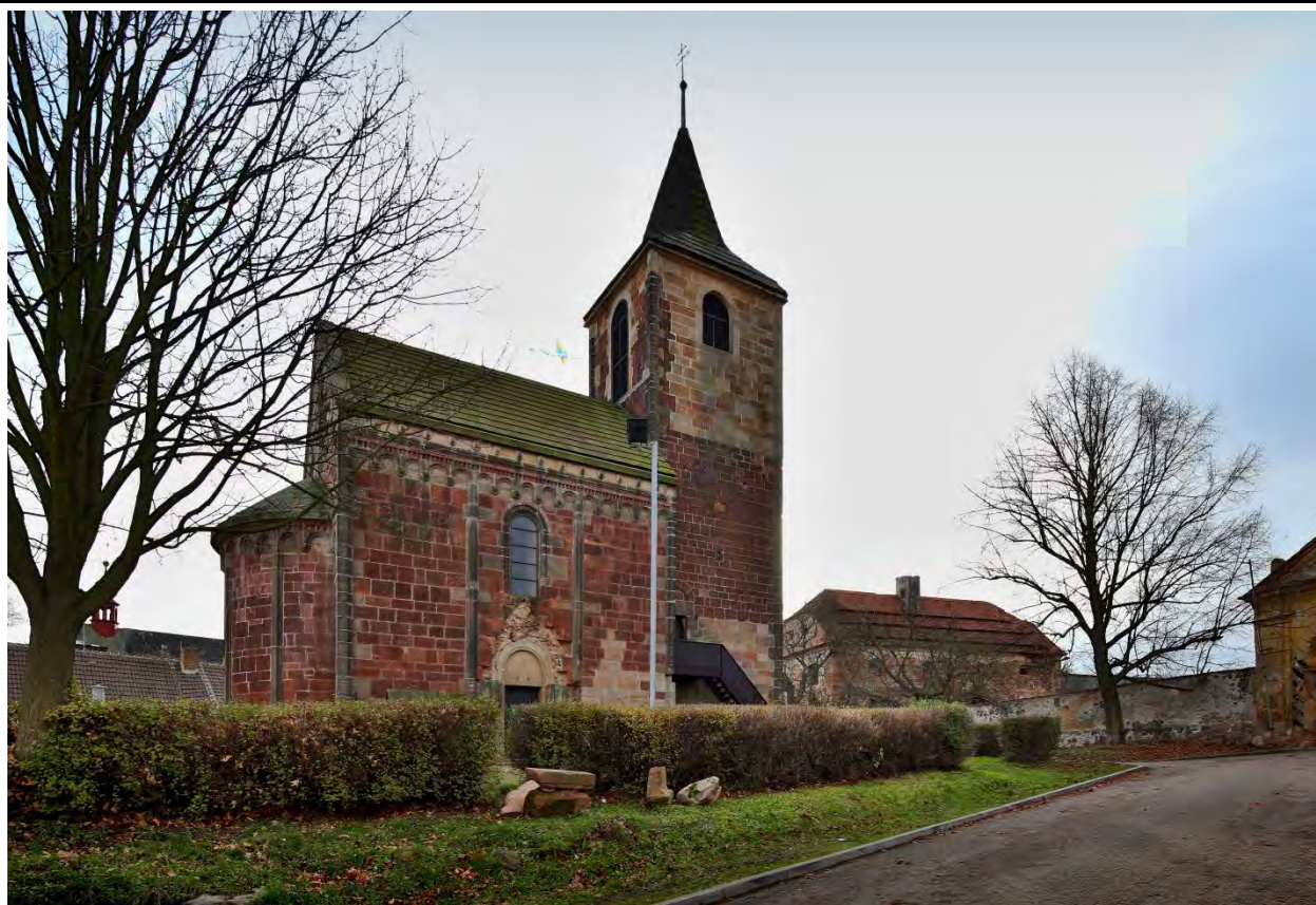
Celkový pohled od severovýchodu. Foto: Kateřina Neumannová 2017.
