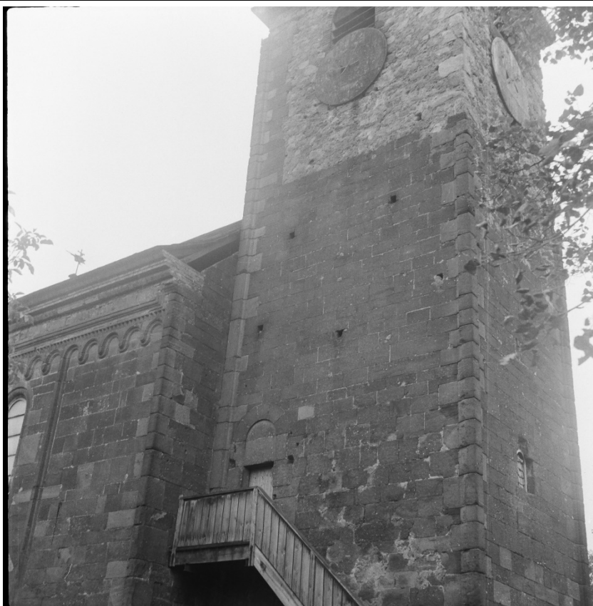
Věž v pohledu od severozápadu. Foto: 1971, sbírka negativů NPÚ ÚOP v Ústí n. L., sign. 4482.
