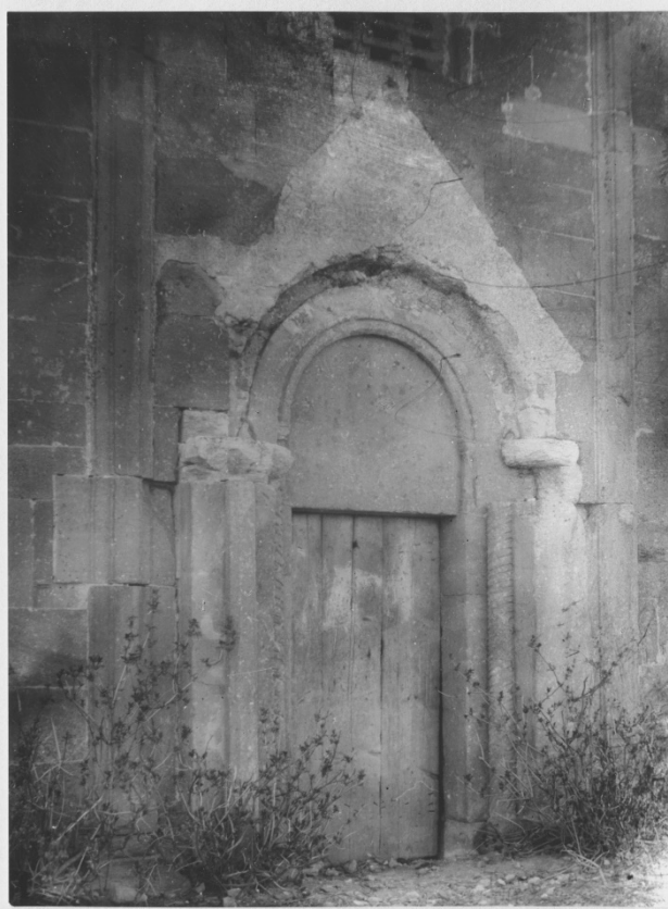
Severní portál lodi v pohledu od severovýchodu. Foto: 1919, sbírka negativů NPÚ GŘ, sign. N000031.
