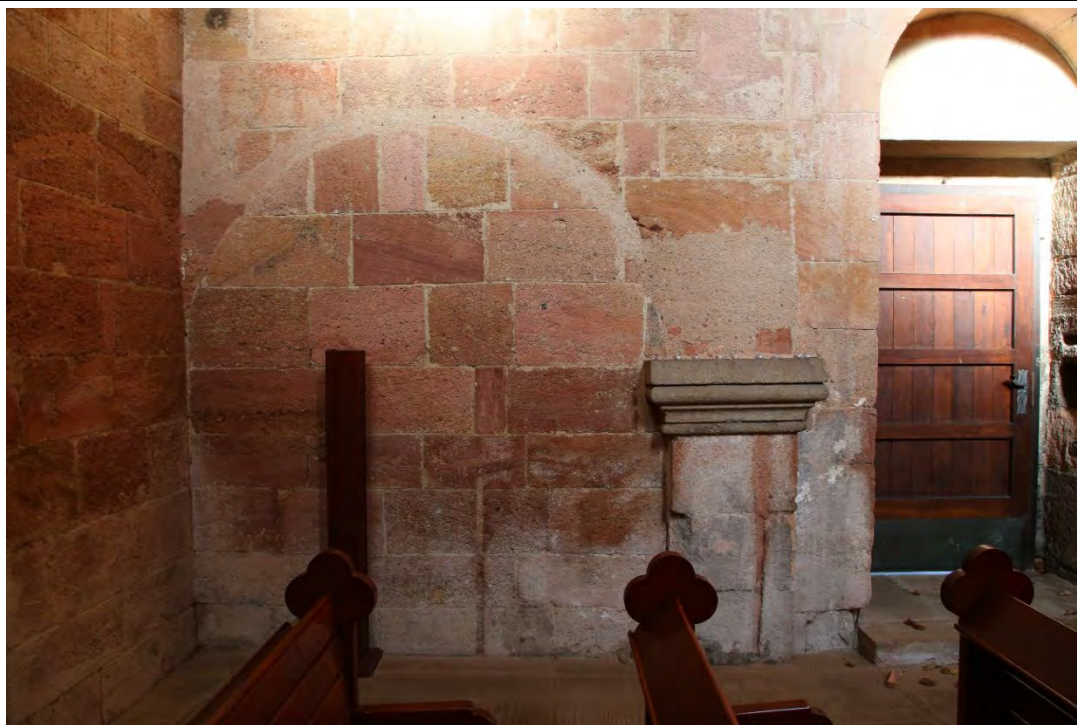
Detail severní stěny lodi v místě bývalé tribuny s dochovaným polopilířem a patrným obloukem pro zavázání čela klenby. Foto: Kateřina Neumannová 2017.
