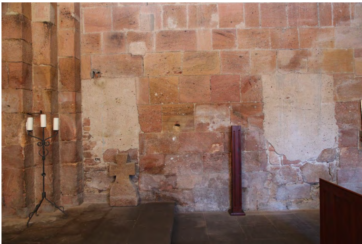
Čelní pohled na východní poloviny jižní stěny lodi s patrnou dvojicí mladších zarděných otvorů. Foto: Kateřina Neumannová 2017.
