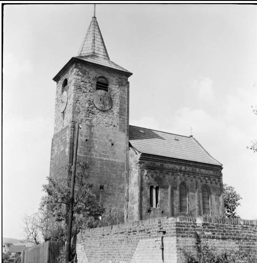
Celkový pohled od jihozápadu. Foto: 1963, sbírka negativů NPÚ ÚOP v Ústí n. L., sign. 9123.
