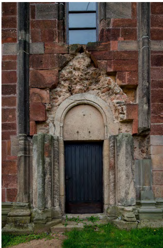
Čelní pohled na severní vstupní portál lodi. Foto: Kateřina Neumannová 2017.
