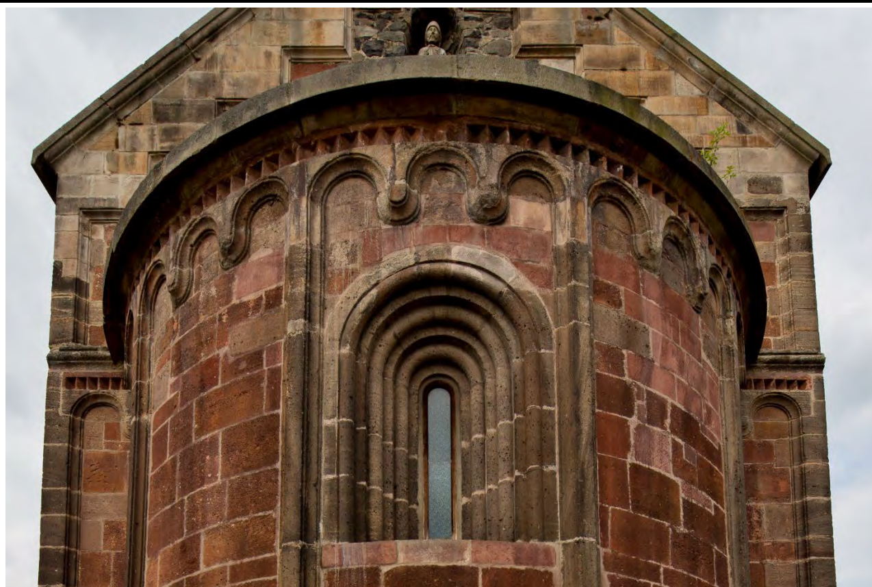
Vrchní část apsidy s osovým oknem v pohledu od východu. Foto: Kateřina Neumannová 2017.
