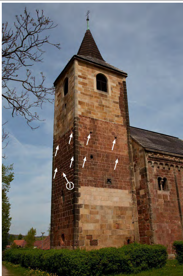
Věž v pohledu od jihozápadu. 1 – vyústění odtokového žlabu na úrovni podlahy druhého patra věže, šipkami jsou označeny kapsy po trámcích stavebního lešení. Foto: Kateřina Neumannová 2017.
