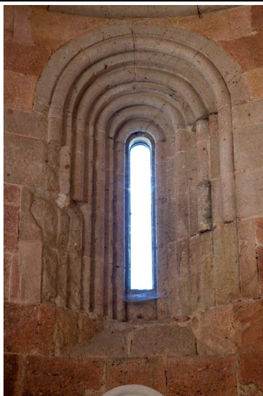
Detail okna apsidy v pohledu od západu. Foto: Kateřina Neumannová 2017.
