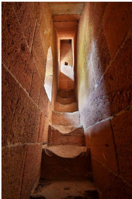
Pohled k západu do schodiště v tloušče jižní zdi věže. Ve stupnici schodišťového stupně zcela dole je zřetelný maltou vyplněný důlek, který se nachází na všech stupních a také parapetech okének schodiště a prazích portálů. Foto: Kateřina Neumannová 2017.
