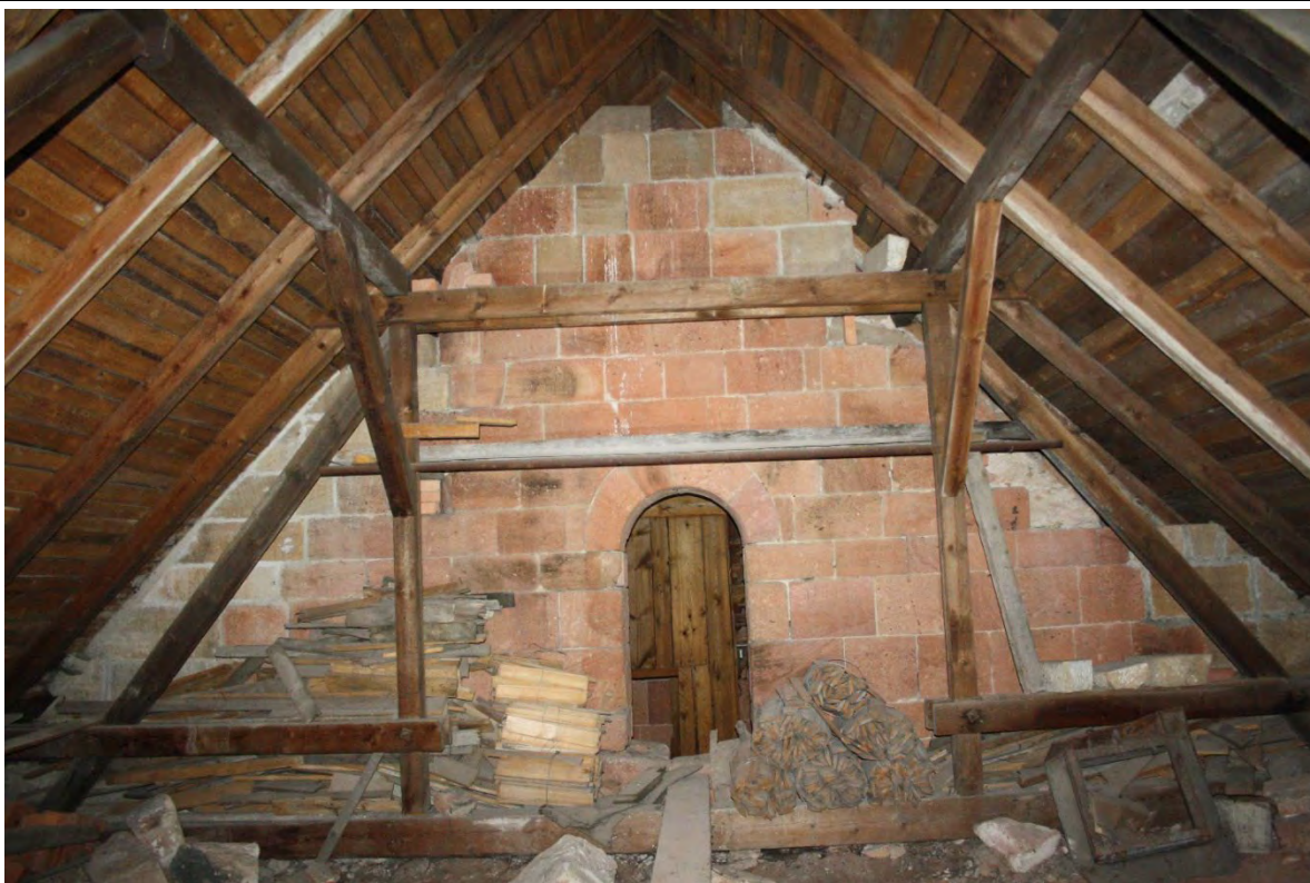
Pohled od východu do krovu nad lodí se vstupem z druhého patra věže. Foto: Jaroslav Skopec 2016.
