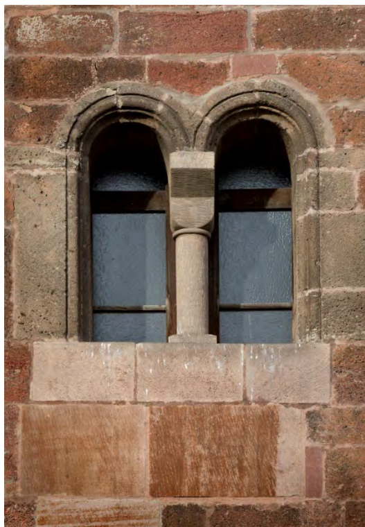
Čelní pohled na jihozápadní sdružené okno lodi. Foto: Kateřina Neumannová 2017.
