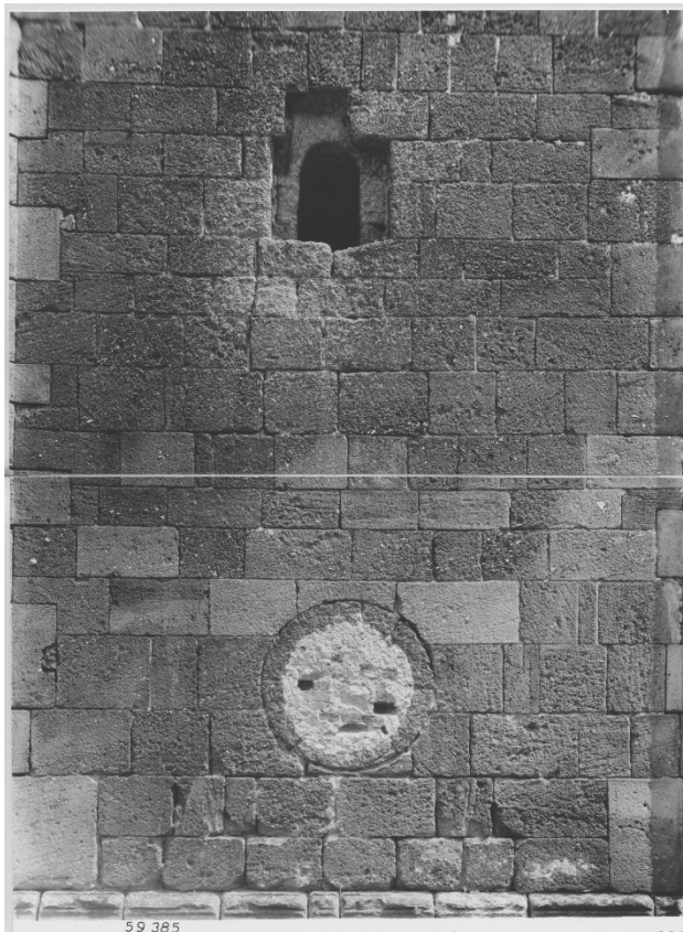
Spodní partie západního průčelí věže. Foto: 1953, sbírka negativů NPÚ GŘ, sign. N059385.
