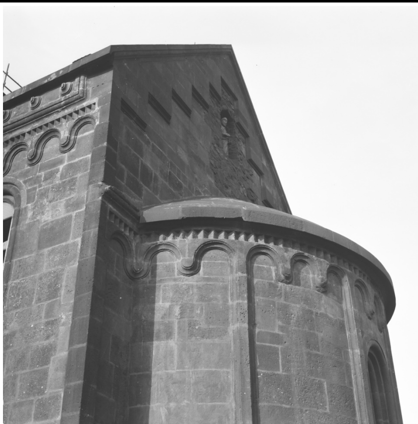
Východní strana lodi s apsidou v pohledu od jihovýchodu. Foto: 1984, sbírka negativů NPÚ ÚOP v Ústí n. L., sign. 73436.
