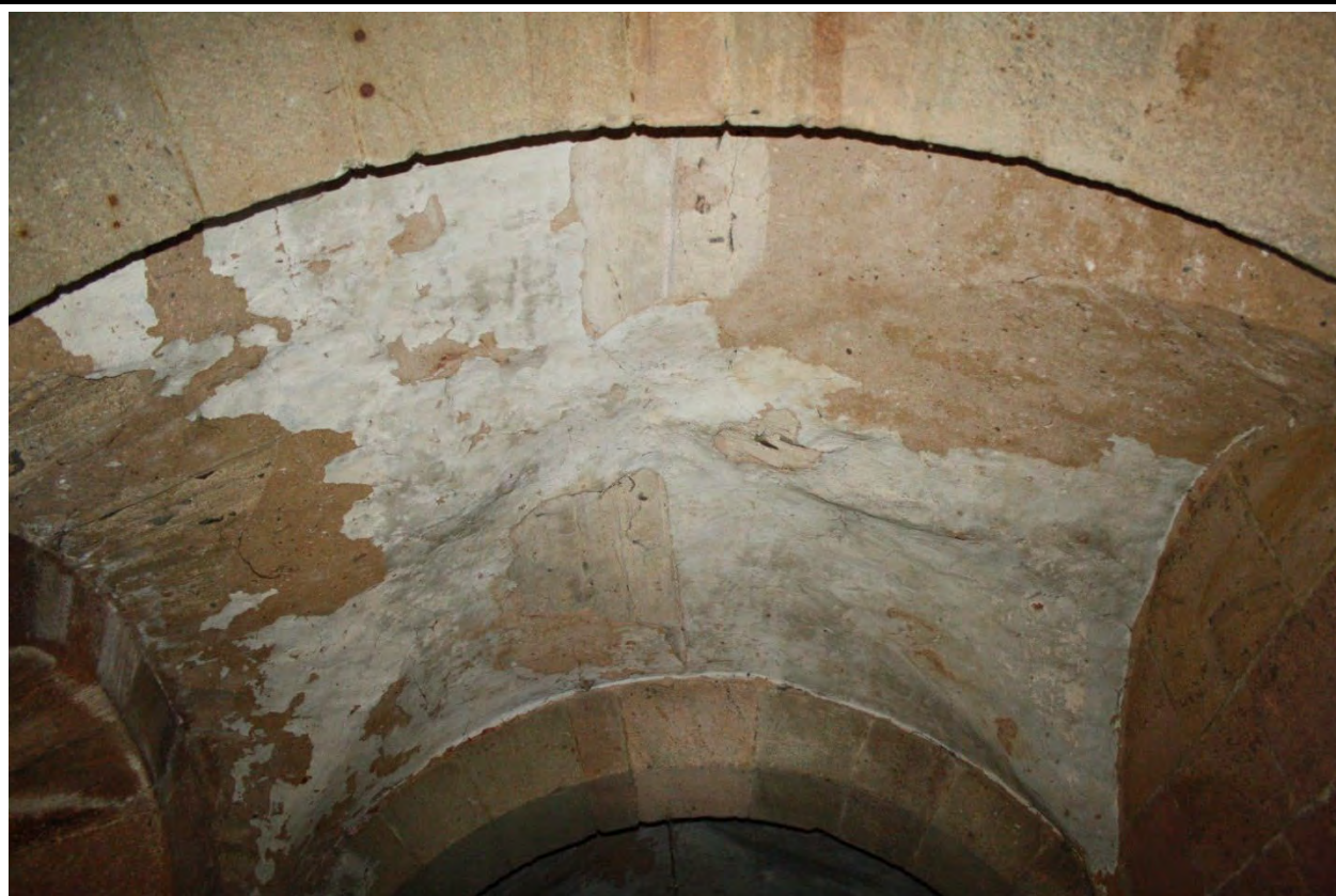
Východní klenební pole podvěží v pohledu od východu s patrnými otisky v maltě po prknech šalování. Foto: Kateřina Neumannová 2017.
