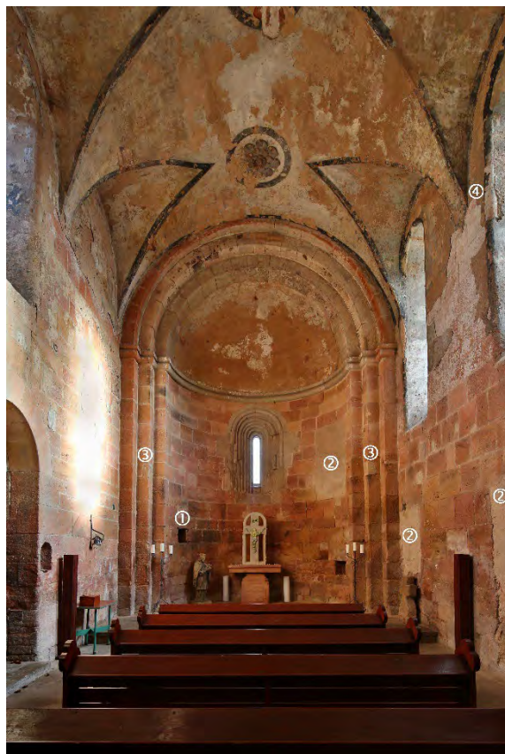
Pohled do lodi od západu. 1 – výklenek sanktuária, 2 – zazděné mladší otvory, 3 – zazděné kapsy, do kterých mohl být osazen trám s Kalvárií, 4 – dobře patrná část oblouku vnitřní profilace románského okna. Foto: Kateřina Neumannová 2017.
