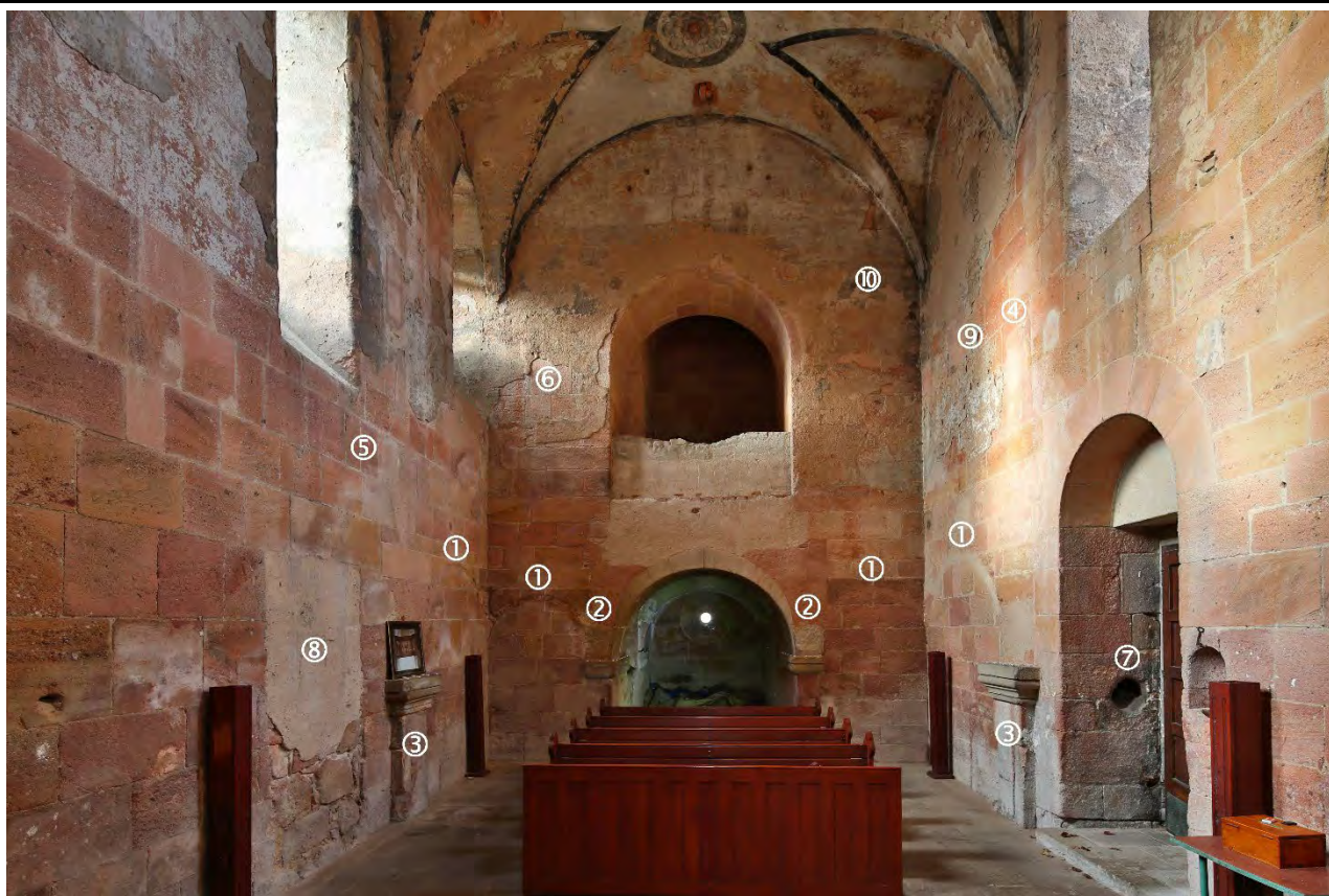
Pohled do lodi od východu. 1 – čelní oblouky kleneb románské tribuny, 2 – odsekané výběhy meziklenebních pasů, 3 – polopilíře románské tribuny, 4 – otisk poprsní zídky románské tribuny, 5 – otisk schodiště na románskou tribunu, 6 – kvádr s rytými ryskami, 7 – pochva pro zasouvání závory, 8 – zazděný mladší vstupní otvor, 9 – rytiny ze 17. století, 10 – rytiny z 18. století. Foto: Kateřina Neumannová 2017.
