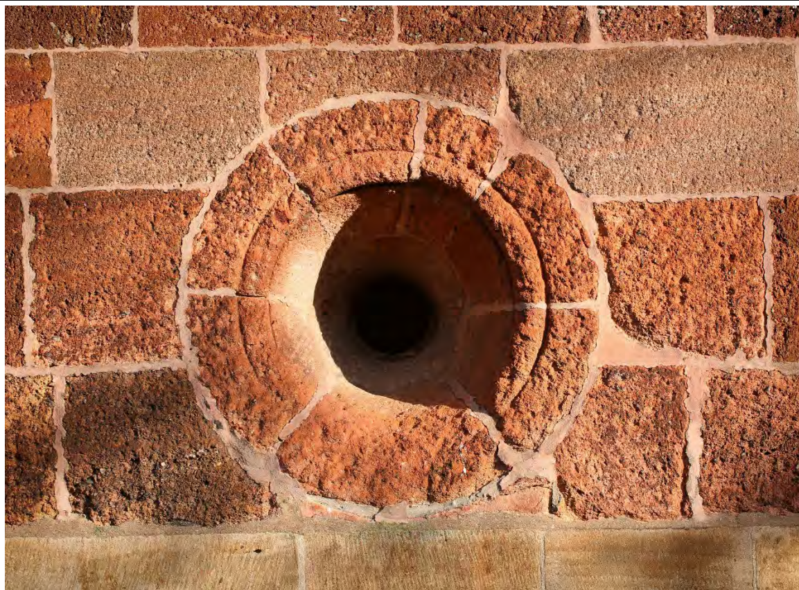
Čelní pohled od západu na kruhové okno podvěží. Foto: Kateřina Neumannová 2017.
