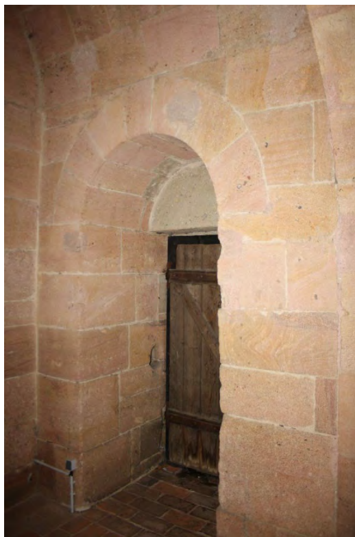
Vstup do 1. patra věže z exteriéru v pohledu od jihovýchodu. Foto: Jaroslav Skopec 2017.
