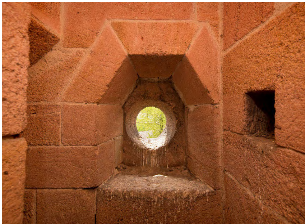
Čelní pohled od severu na horní okenní otvor schodiště v tloušťce zdi. Uprostřed parapetu je opět viditelný maltou vyplněný důlek. Napravo okna je patrná kapsa po trámku lešení v západním zdivu. Foto: Kateřina Neumannová 2017.
