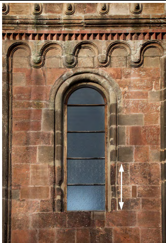
Čelní pohled na jižní okno lodi. Šipka označuje snížení parapetu otvoru v 90. letech 16. století. Foto: Kateřina Neumannová 2017.
