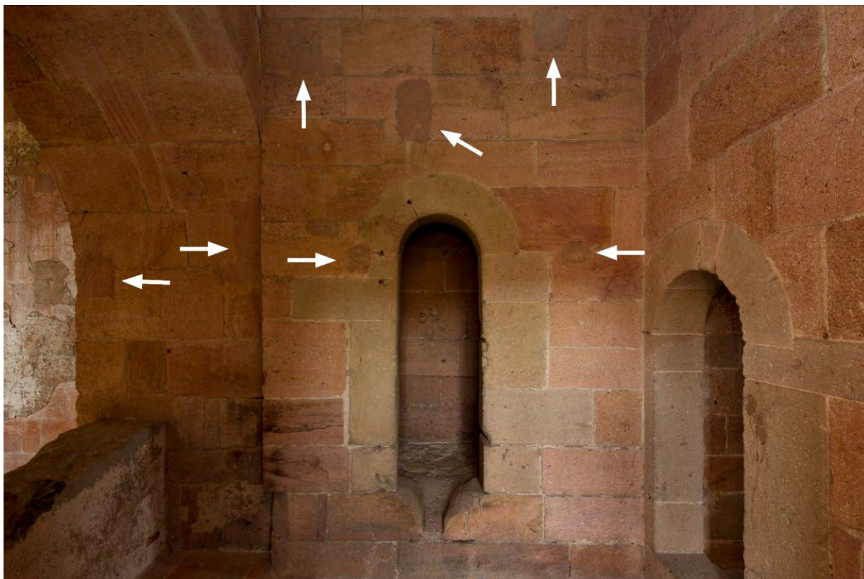
Pohled k jihu do východní prostory prvního patra věže. V čele vstup do schodiště v tloušťce zdi, napravo vstup do západní prostory s trezorem, vlevo široký klenutý otvor s parapetem na někdejší románskou tribunu. Šipkami jsou označeny zazděné kapsy dřevěných trámčích, které sem byly dodatečně vkládány v době profanisace kostela v 19. století. Foto: Kateřina Neumannová 2017.
